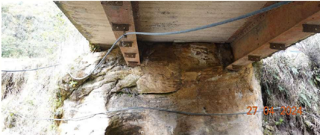
Source: ZJ Ingenieros Estructurales SAS. Rock supports a bridge.
