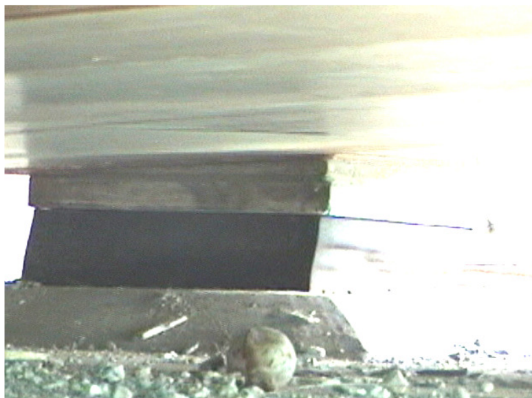
Foto 1. Apoyo en t=0 meses con el peso propio sin losa
