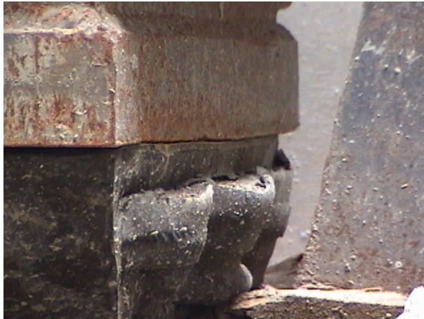
Foto 3. Apoyo en t=3 meses con el peso propio y carga de losa parcial
