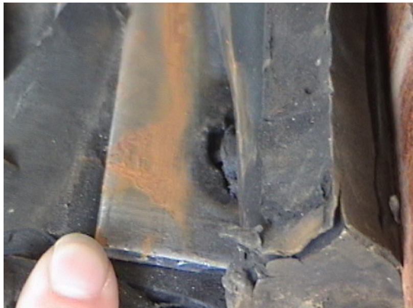
Foto 7. Apoyo en t=6 meses con el peso propio y carga de losa parcial
