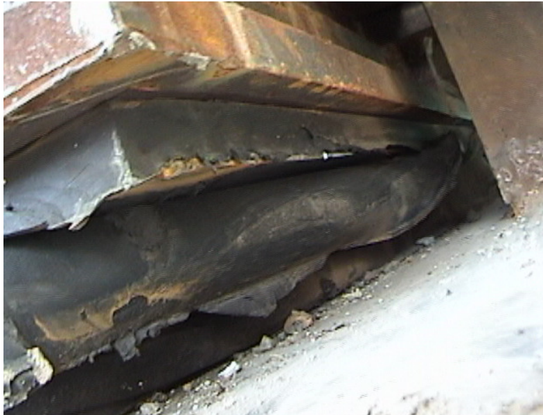
Foto 6. Apoyo en t=6 meses con el peso propio y carga de losa parcial
